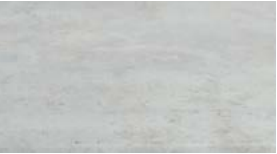
Vit rå betong
