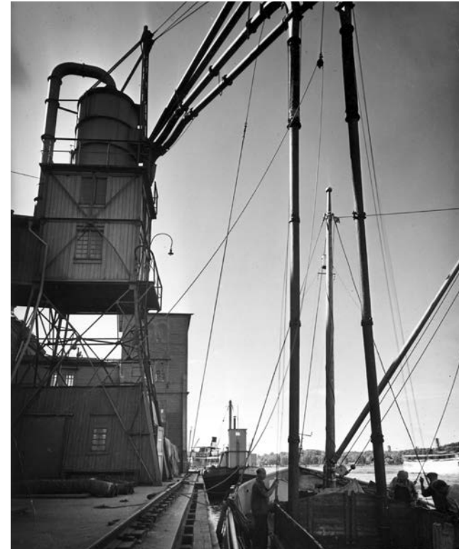
Här sugs spannmålen direkt ur fartygets lastrum. Foto: KF Arkiv
