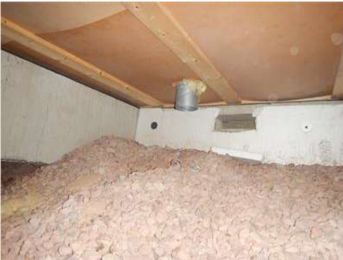
Tilluft till kaminen tas via grunden.
